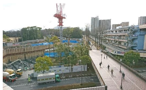
中央図書館建築現場・レンガ坂(2022.1.25撮影)
